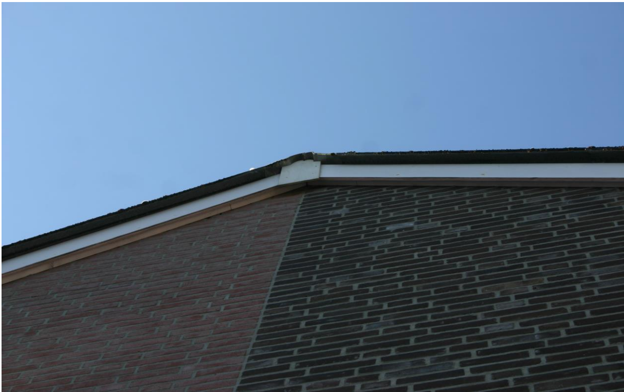
Figuur 4.2.2. De kopgevels zijn voorzien van een nauw aansluitende dakbetimmering, waardoor vleermuizen niet het gebouw in kunnen.
