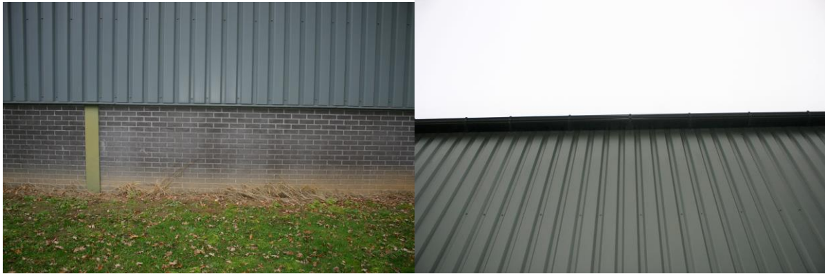
Figuur 4.2.1. De loods is deels opgemetseld en heeft deels wanden van damwand. Doordat kieren ontbreken en het materiaal bovendien te glad is en niet goed isoleert, is dit gebouw ongeschikt voor vleermuisverblijven.
