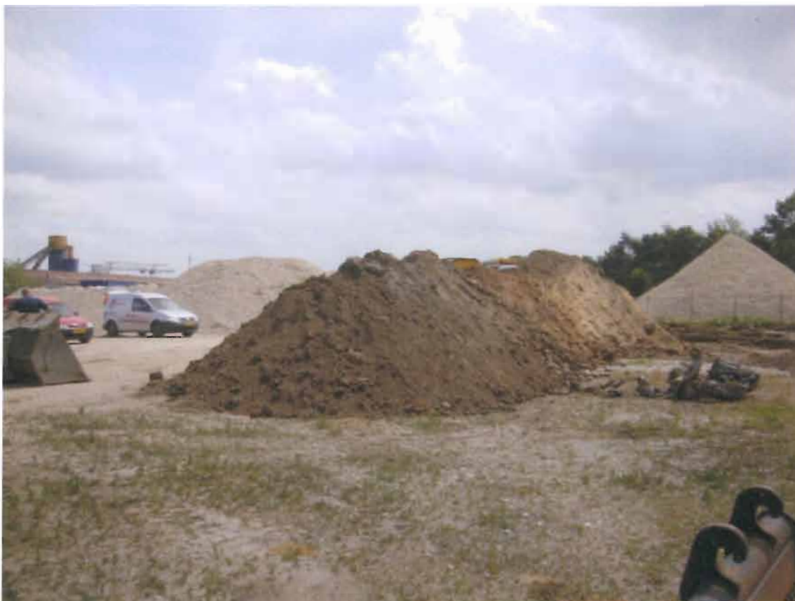
foto 7: depot (II) zintuiglijk verontreinigde grond c.q. bodemvreemd materiaal (gezien vanuit het noordwesten, 6 juni 2011)
