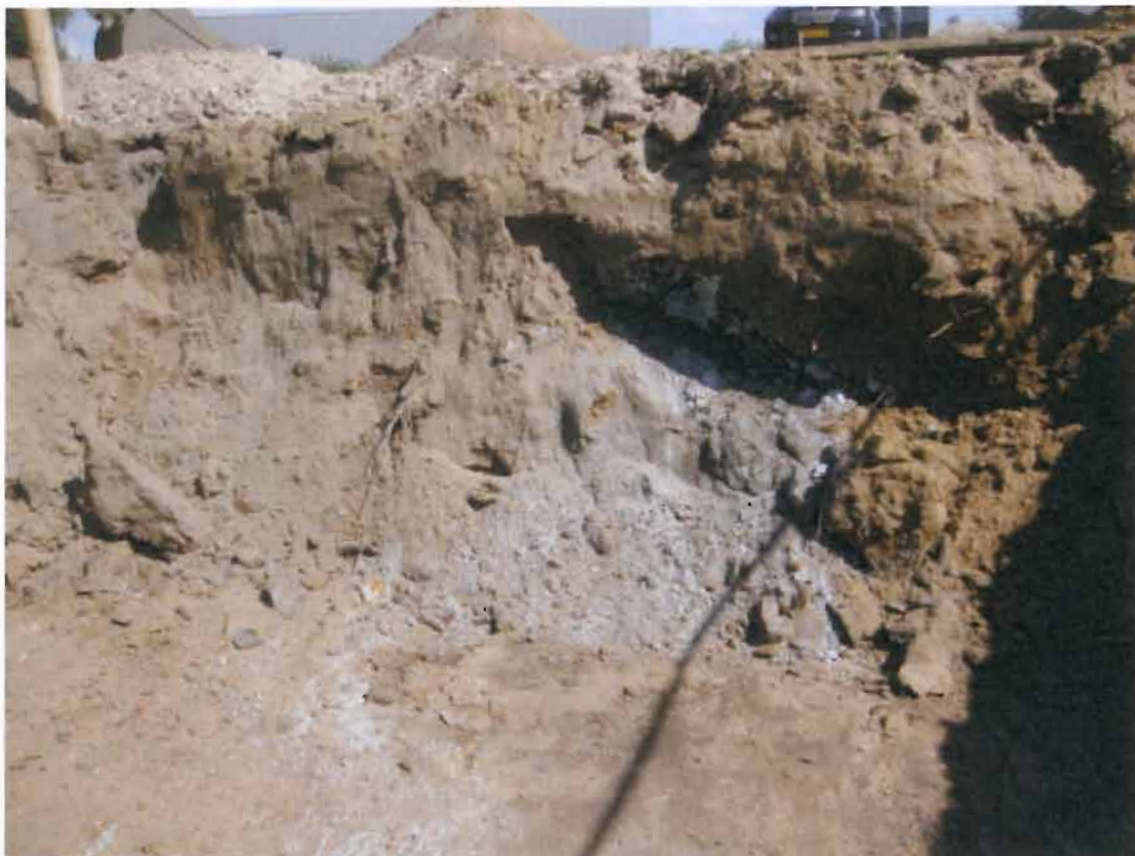
foto 1: noordelijke putwand ontgravingsput sterk verontreinigde grond (gezien vanuit het zuiden, 1 juni 2011)
