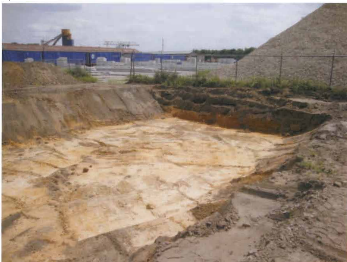
foto 5: overzicht zuidelijke deel ontgravingsput (gezien vanuit het noordwesten, 6 juni 2011)
