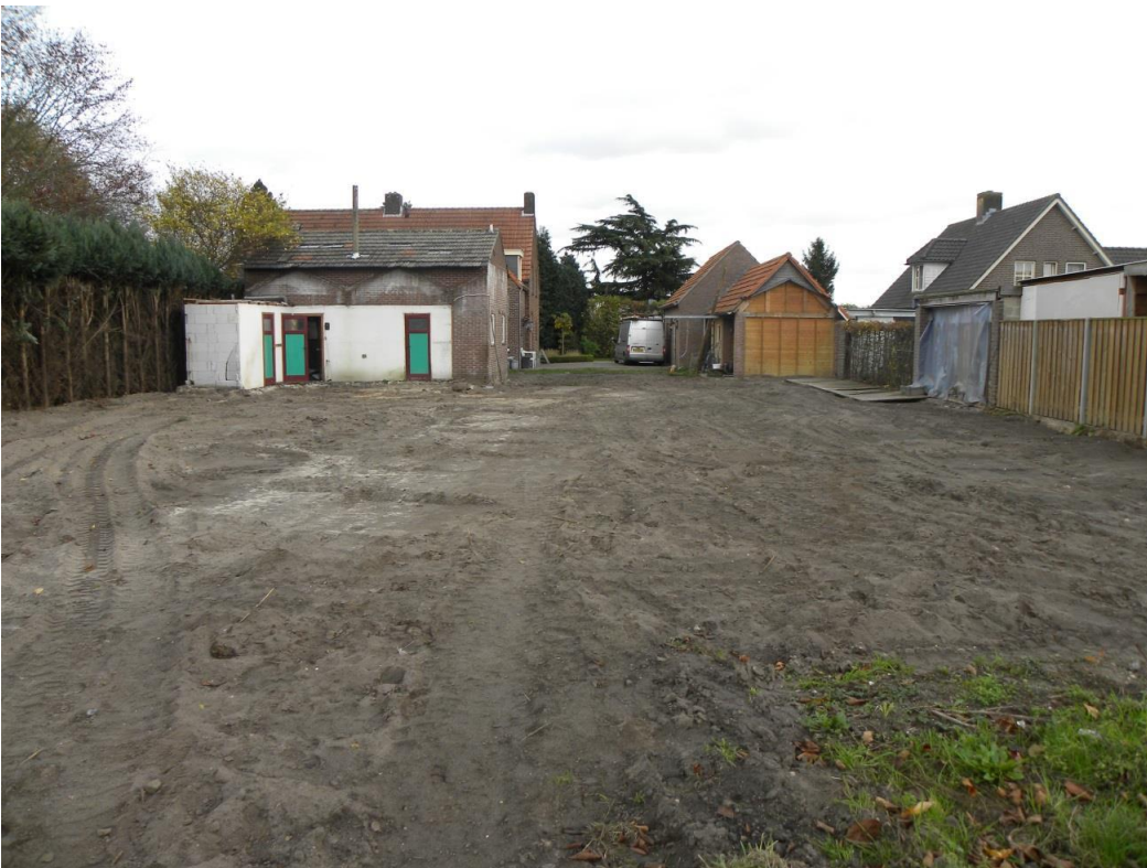
Foto's bestaande situatie
