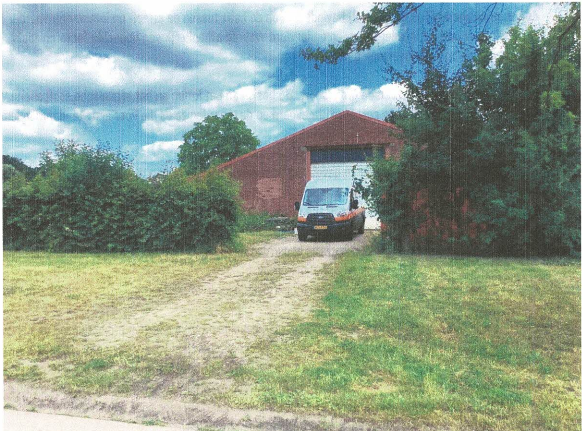
Foto van de voorzijde van de onderzoekslocatie – d.d. 20 juni 2022
