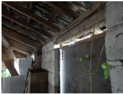
buitenmuur halfsteens metselwerk
