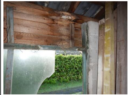
geen kit/stopverf in kozijnen
