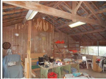
impressie loods, onverdacht
