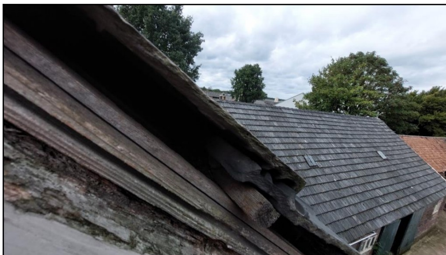
Figuur 4.2.1. De ruimtes onder de gevelpannen zijn geïnspecteerd; vogelnesten zijn afwezig.
