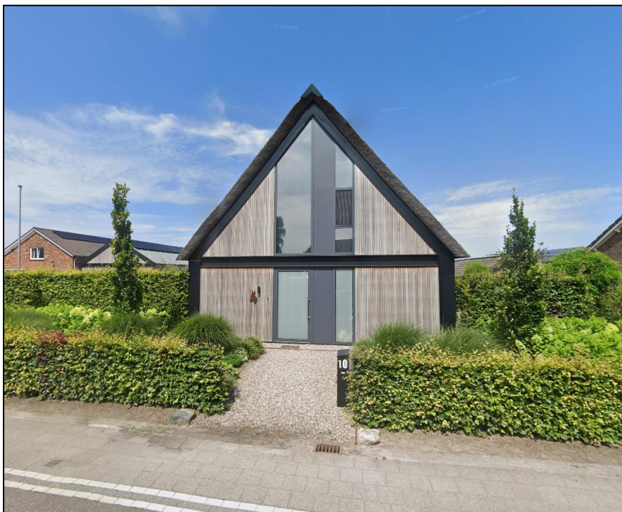
Figuur 2.4: Bestaande woning De Hees 10
