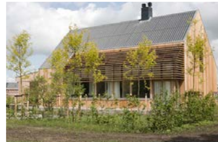
De gevelbekleding is van hout. Optioneel zijn ook de daken van hout, maar dit is niet verplicht.
