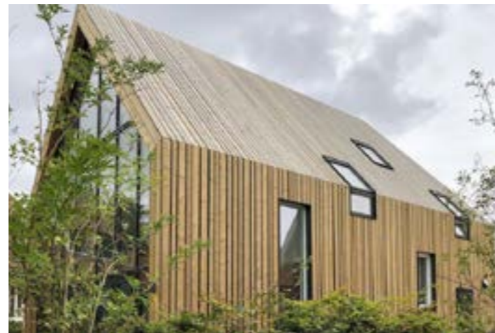
De gevelbekleding is van hout. Optioneel zijn ook de daken van hout, maar dit is niet verplicht.
