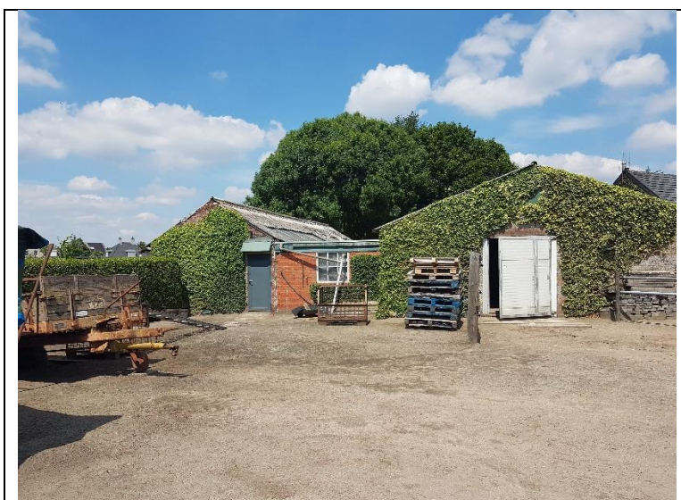
Foto 2: buitenterrein ten zuiden van schuren (gezien vanuit het zuiden, 11 juni 2019)
