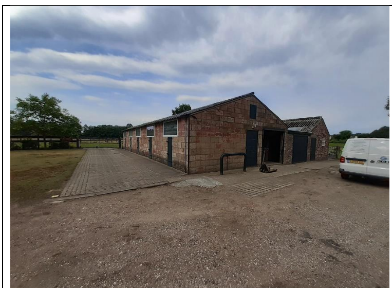
Foto 5: schuren ten zuidwesten van bebouwing (gezien vanuit het noordoosten, 18 juni 2019)
