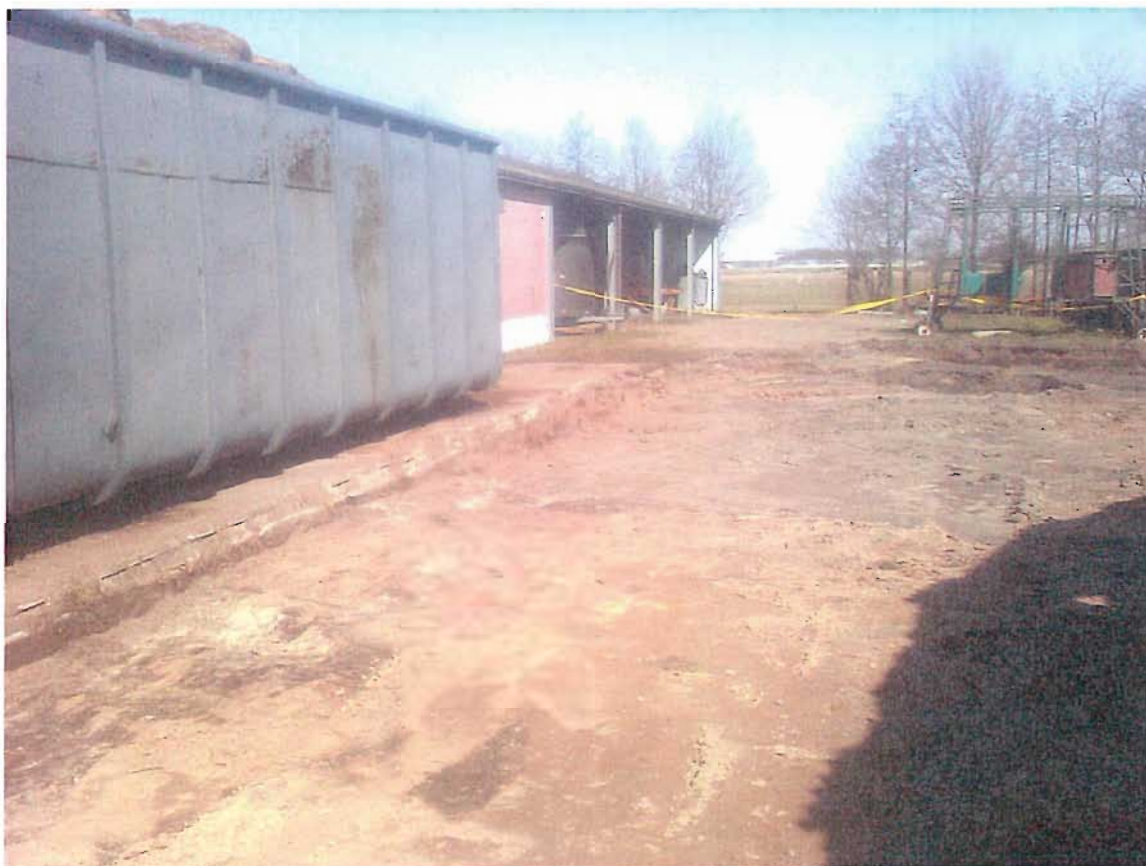
foto 1: ontgravingsput (putbodemp1) na verwijderen asbesthoudend verhardingsmateriaal (gezien vanuit het zuidwesten, 26 maart 2013)
