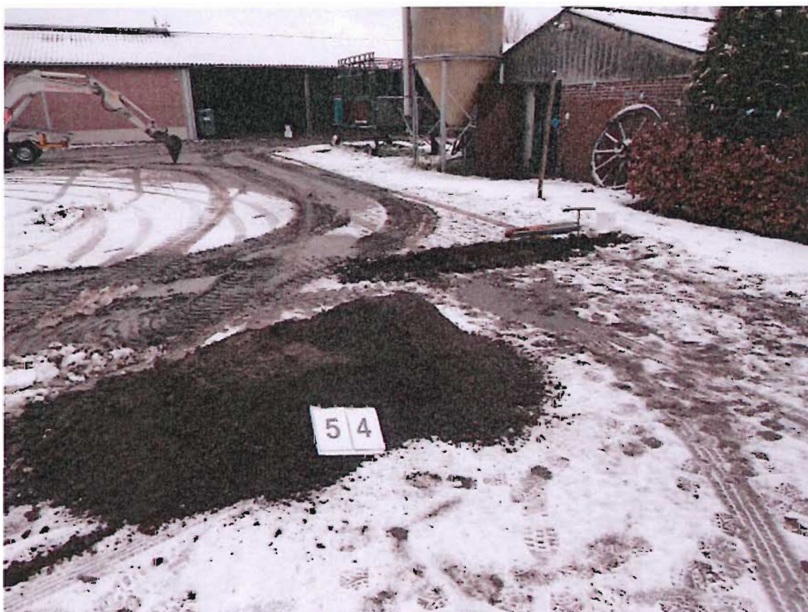
foto 8: uitkomende materiaal inspectiesleuf S4 (traject 0-0,3 m-mv, 8 februari 2013)
