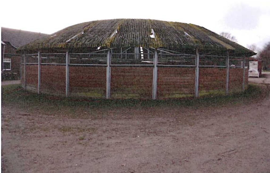
Foto 1: Stadmolen met dakbedekking van bitumen golfplaten (gezien vanuit het noordoosten, 2 januari 2013)
