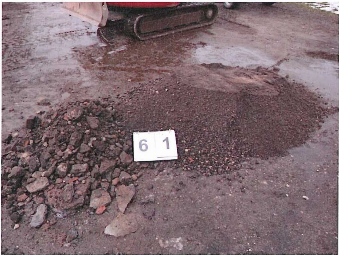
foto 17: uitkomende materiaal inspectiesleuf S11 (traject 0-0,3 m-mv, 8 februari 2013)
