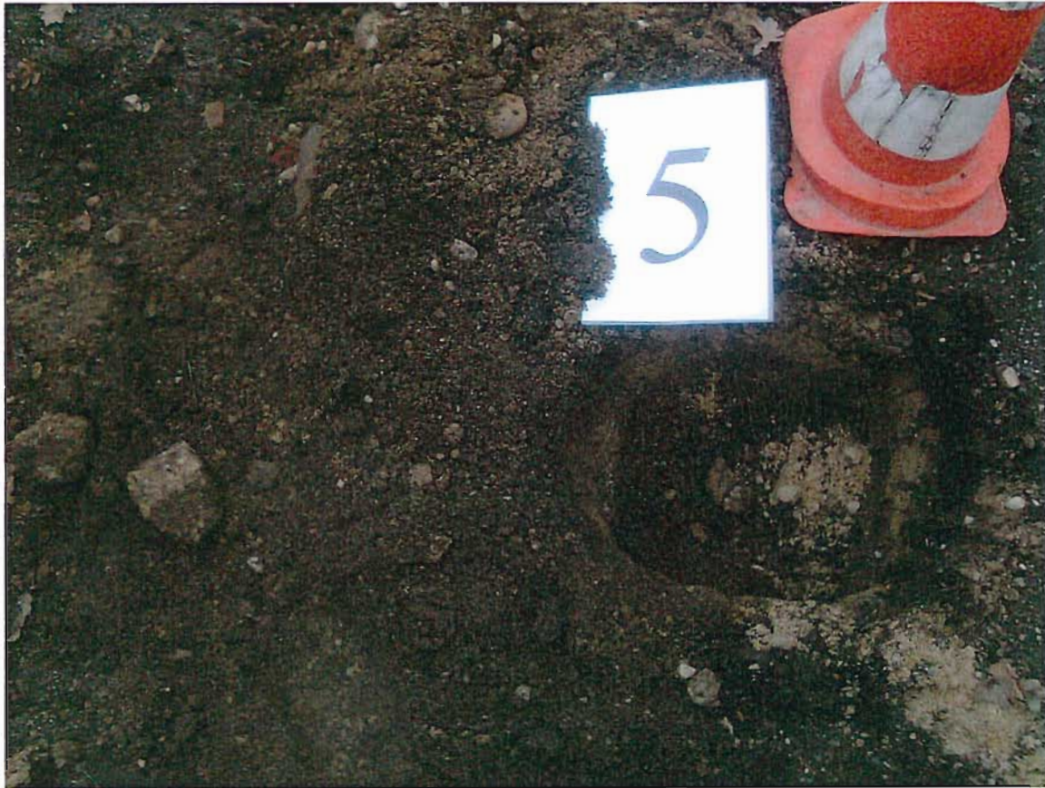
Foto 9: Uitkomend materiaal inspectiegat 5 gebroken puin- en asfaltverharding (7 januari 2013)
