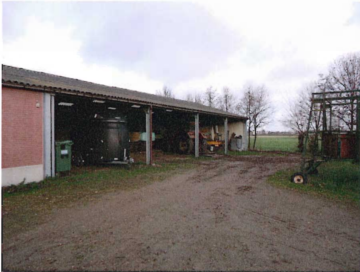
Foto 3: Opslagruimte / veldschuur met bovengrondse dieseltank van circa 600 liter (gezien vanuit het zuidwesten, 2 januari 2013)
