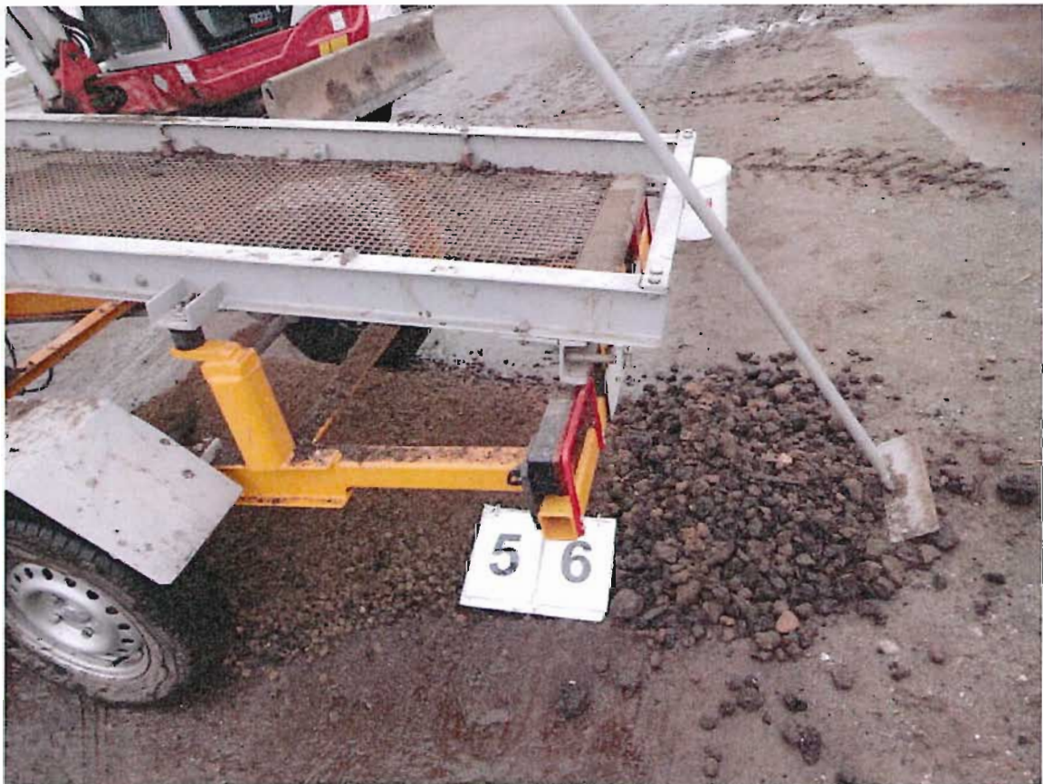
foto 10: gezeefd (< 16mm) uitkomende materiaal inspectiesleuf S6 (traject 0-0,2 m-mv, 8 februari 2013)
