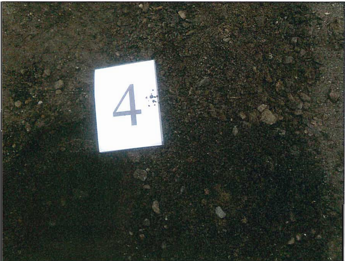
Foto 8: Uitkomend materiaal inspectiegat 4 gebroken puin- en asfaltverharding (7 januari 2013)
