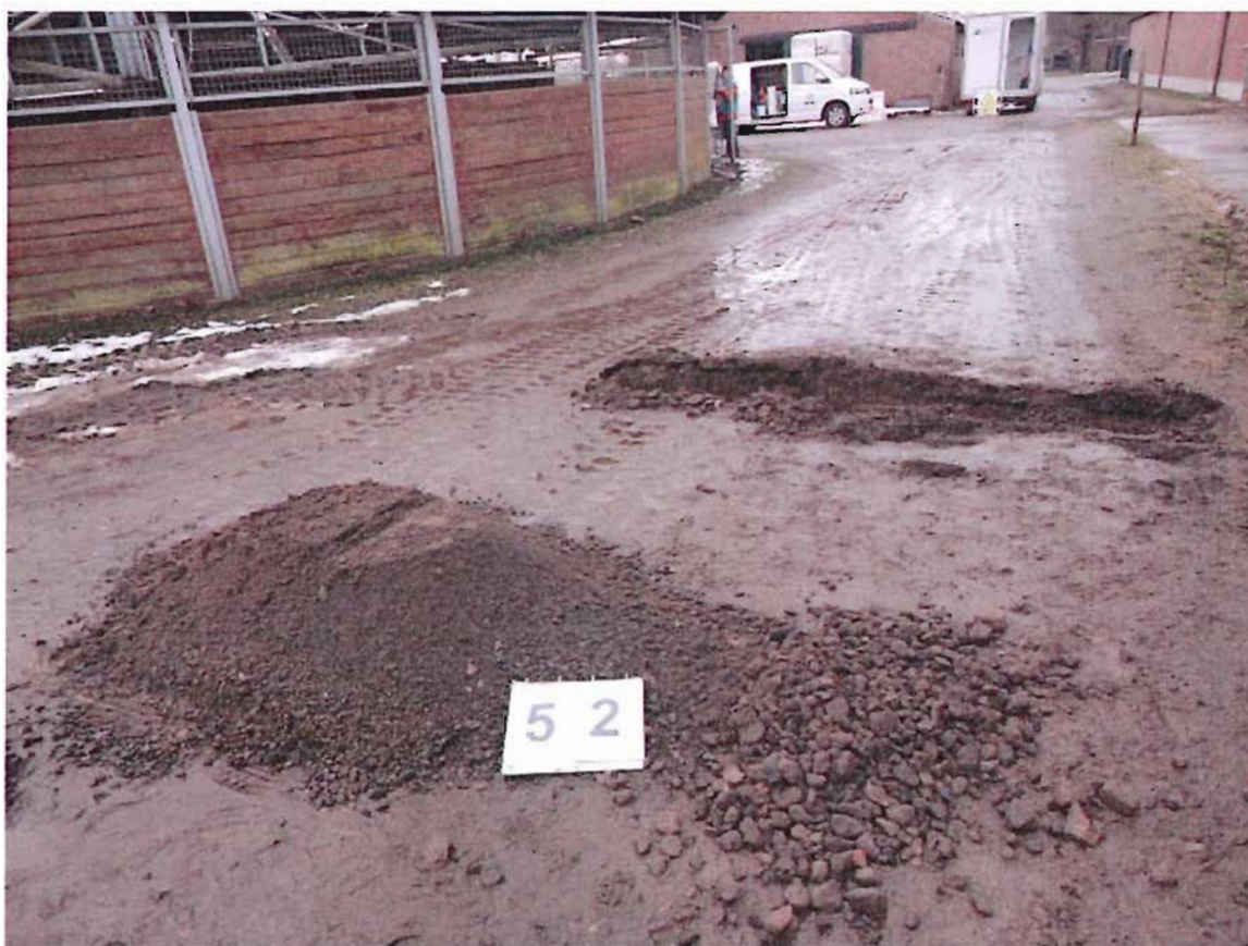
foto 5: uitkomende materiaal inspectiesleuf S2 (traject 0-0,2 m-mv, 8 februari 2013)
