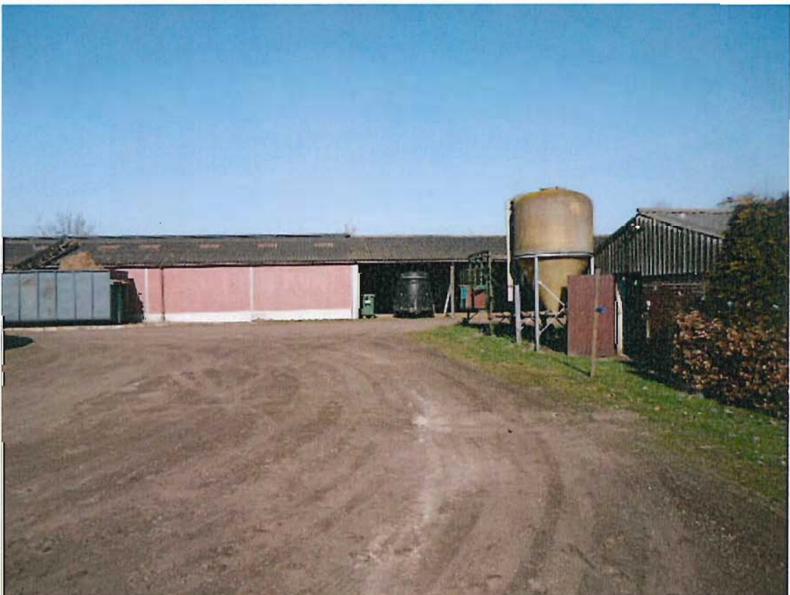
Foto 4: Reeds in januari en februari 2013 onderzochte erfverharding ten zuidwesten van meest oostelijk gelegen paardenstal (gezien vanuit het zuiden, 5 maart 2013)
