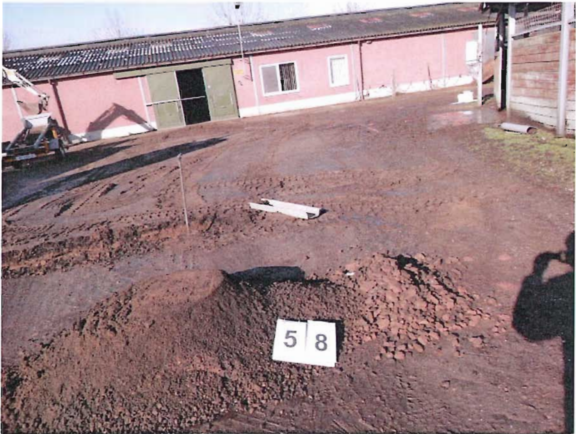
foto 13: uitkomende materiaal inspectiesleuf S8 (traject 0-0,2 m-mv, 8 februari 2013)
