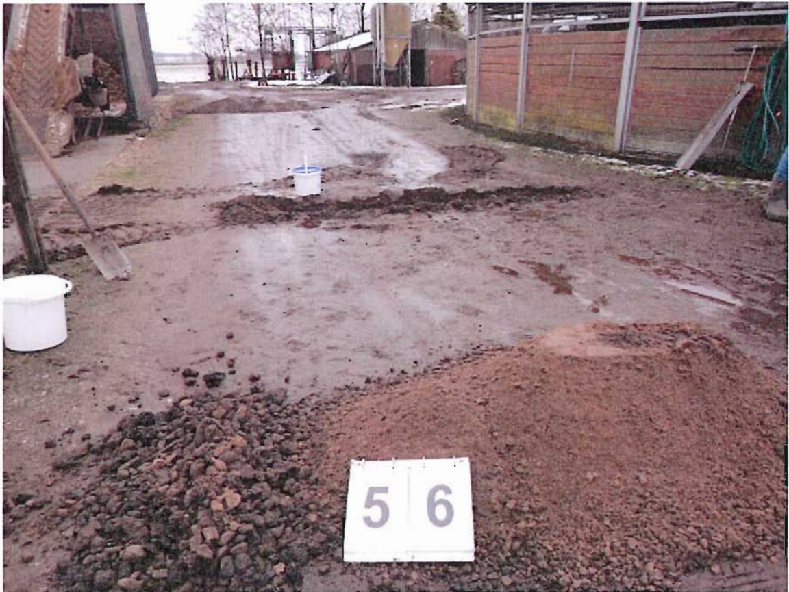
foto 11: uitkomende materiaal inspectiesleuf S6 (traject 0-0,2 m-mv, 8 februari 2013)
