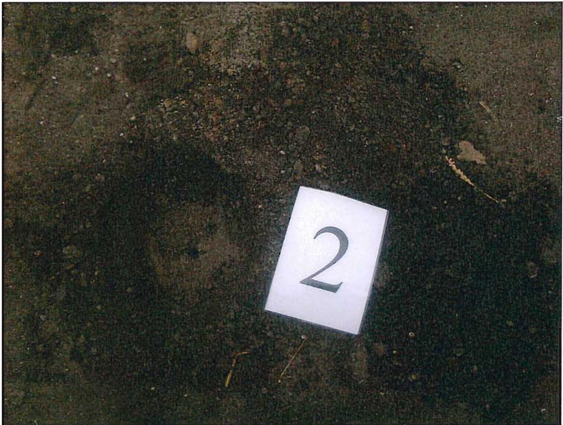
Foto 6: Uitsluitend materiaal inspectiegat 2 gebroken puin- en asfaltverharding (7 januari 2013)
