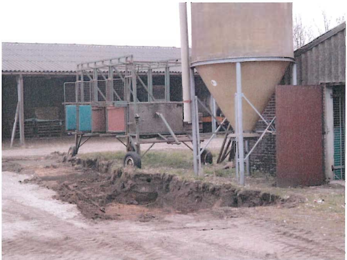
foto 8: aanvullende ontgraving noordoostelijk deel erfverharding, aangrenzend ten zuidwesten meest oostelijk gelegen paardenstal (gezien vanuit het zuiden, 5 april 2013)
