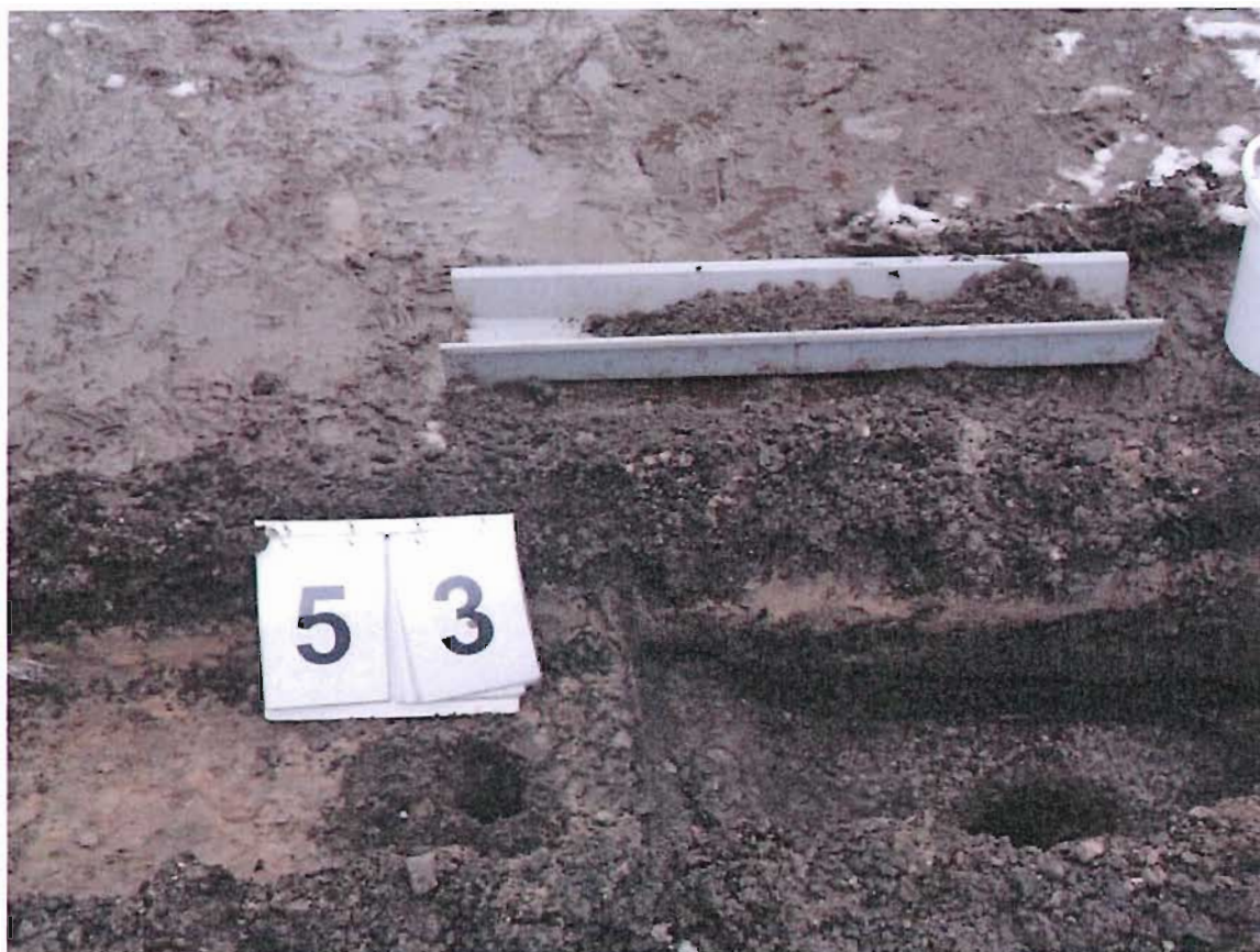
foto 7: uitkomende materiaal inspectiesleuf S3 (traject 0-0,3 m-mv, 8 februari 2013)
