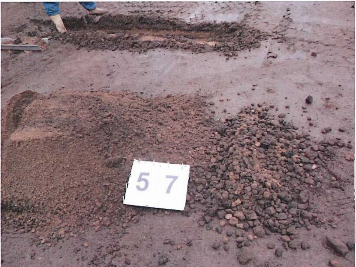
foto 12: uitkomende materiaal inspectiesleuf S7 (traject 0-0,15 m-mv, 8 februari 2013)
