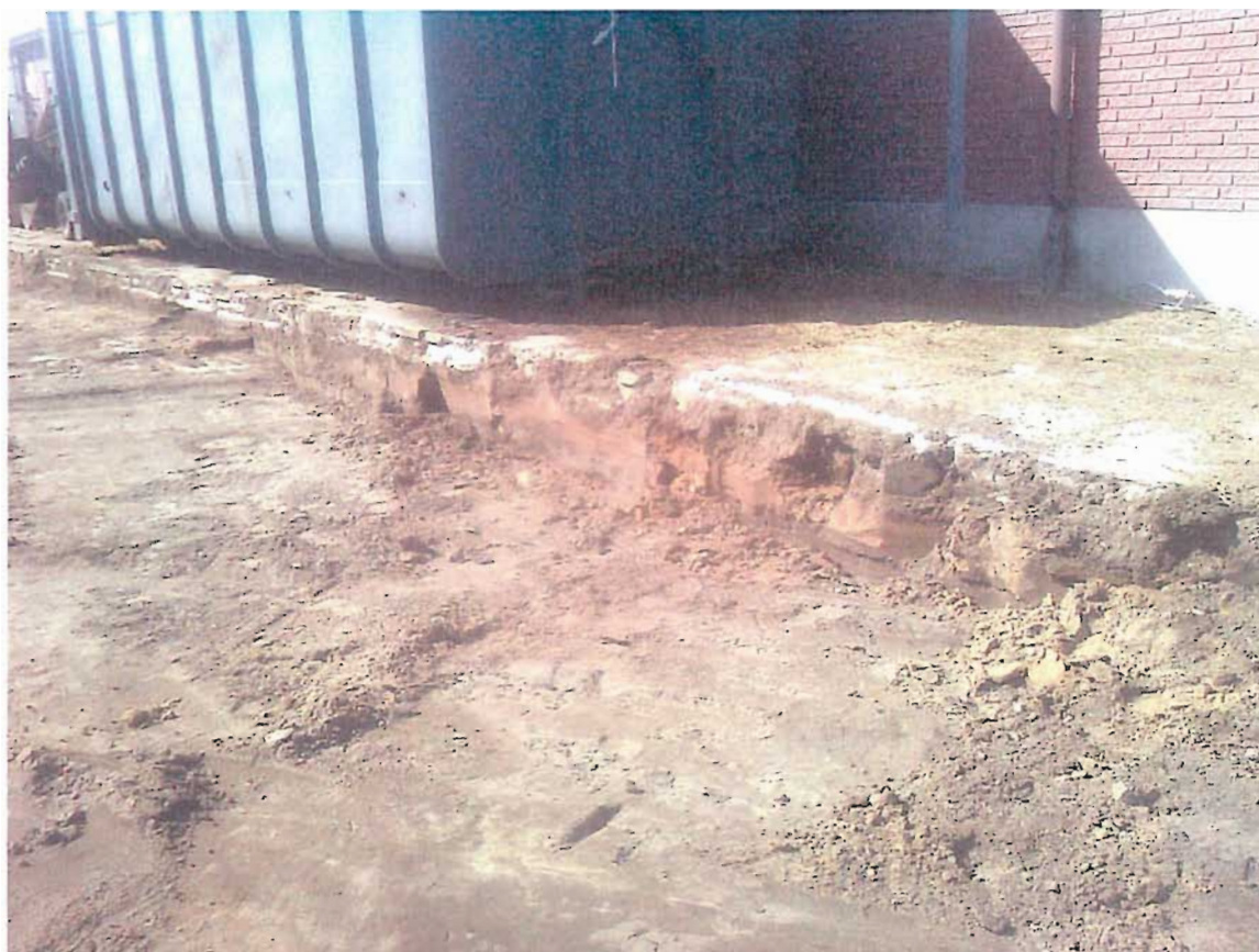
foto 5: putwand W2 (gezien vanuit het oosten, 26 maart 2013)
