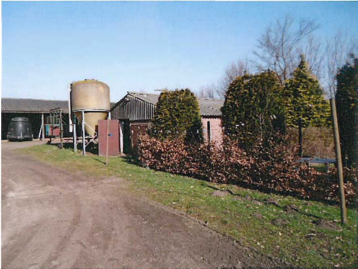
Foto 3: Meest oostelijk gelegen paardenstal met ten zuidoosten daarvan tuin en ten zuidoosten daarvan erfverharding van gebroken asfalt en puin (gezien vanuit het zuiden, 5 maart 2013)
