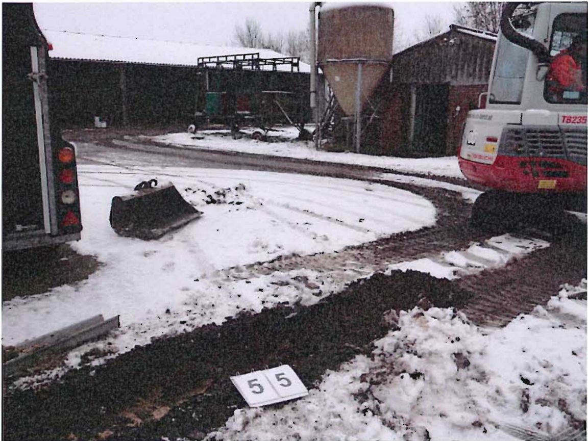
foto 9: uitkomende materiaal inspectiesleuf S% (traject 0-0,2 m-mv, 8 februari 2013)
