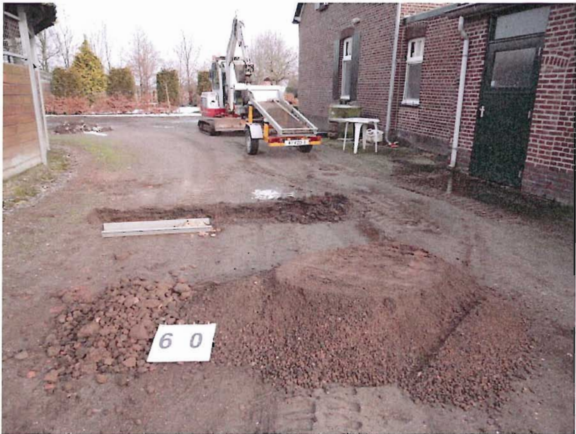
foto 15: uitkomende materiaal inspectiesleuf S10 (traject 0-0,3 m-mv, 8 februari 2013)
