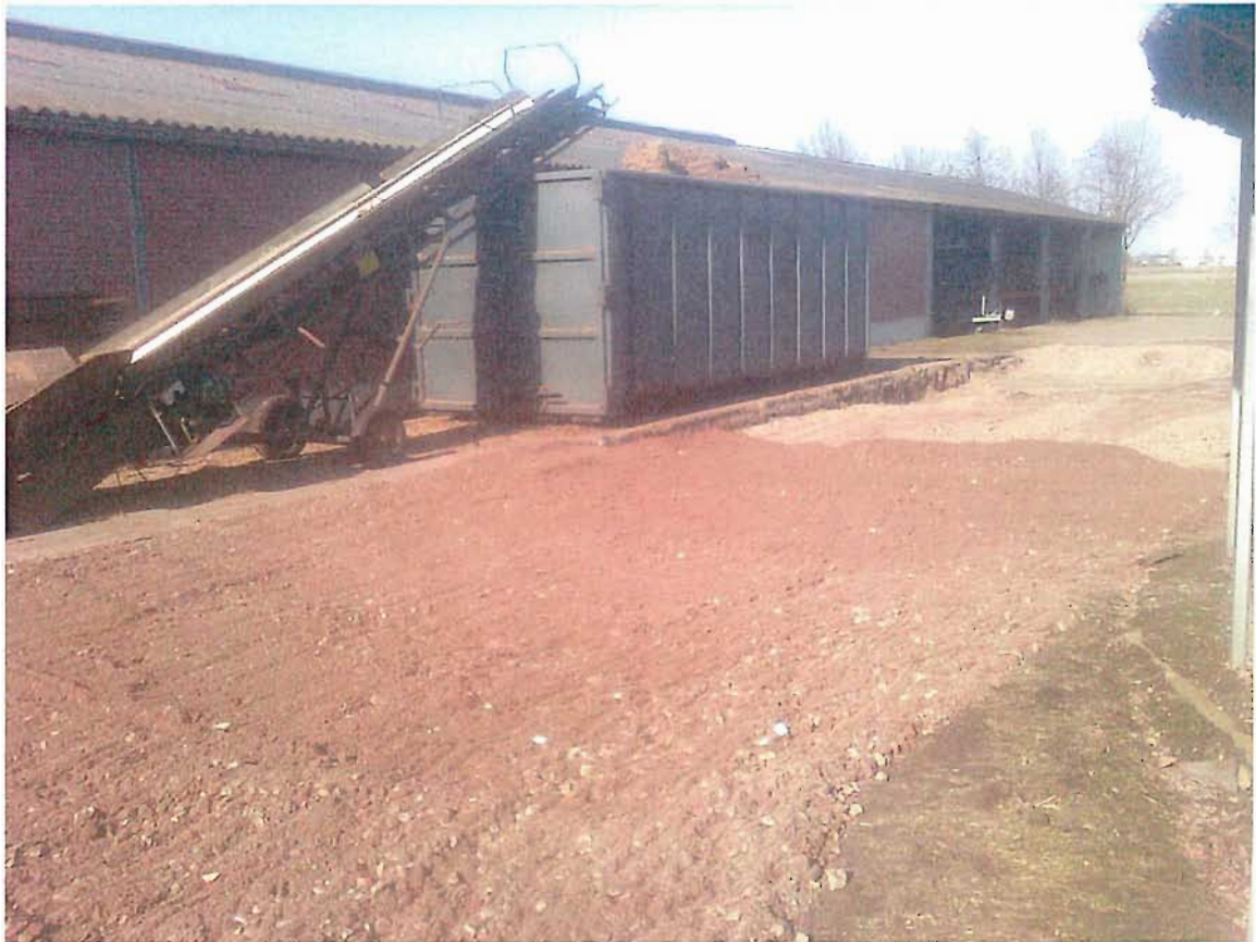
foto 7: aanvullen ontgravingsput ten zuidoosten van meest noordelijk gelegen paardenstal (gezien vanuit het zuidwesten, 26 maart 2013)
