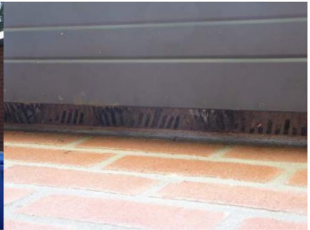
Afbeelding 3. Afsluiting onder de golfplaten (Foto: [REDACTED] Ecoresult B.V.)
