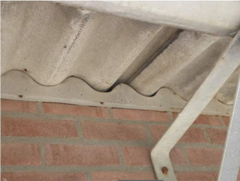
Dichtgemaakte golfplaten. Foto: [redacted] Ecoresult B.V.
