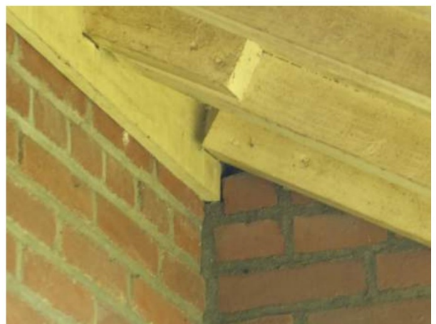
Afbeelding 12: Holte onder dakrand van het woonhuis
