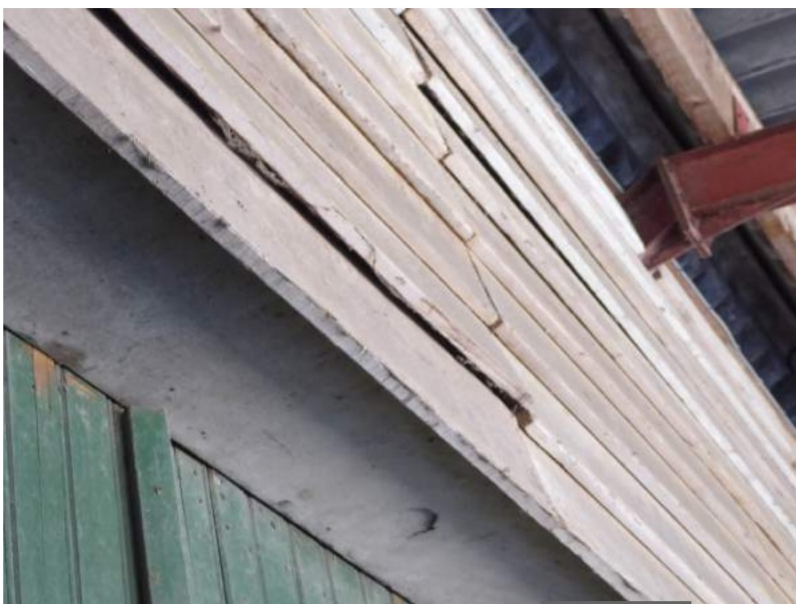
Houten achterwand van open schuur 6 Foto: [redacted] Ecoresult B.V.
