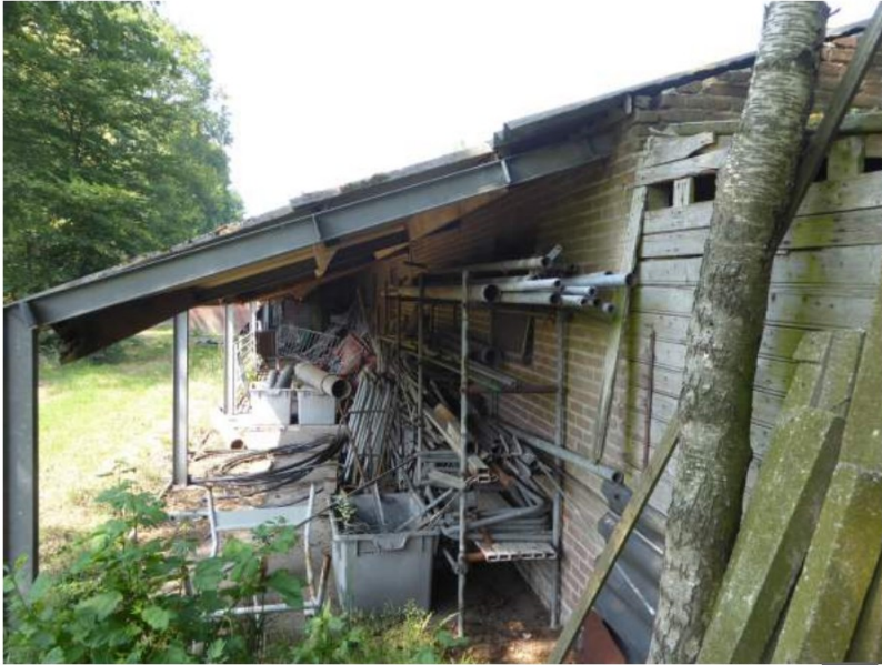
Afdak met opslag aan de achterkant van open schuur 6. Foto: Ecoresult B.V.
