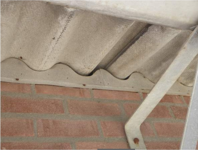
Dichtgemaakte golflaten. Foto: XXXXXXXXXX Ecoresult B.V.
