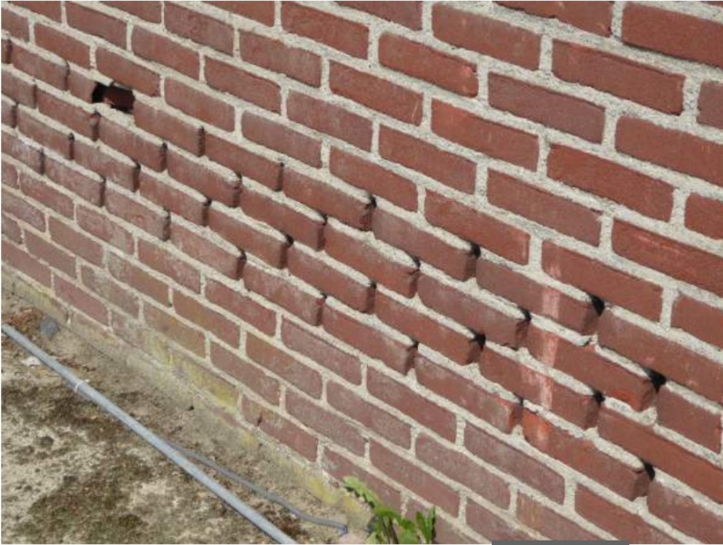
Lage stootvoegen op varkensschuur 2. Foto: [redacted] Ecoresult B.V.
