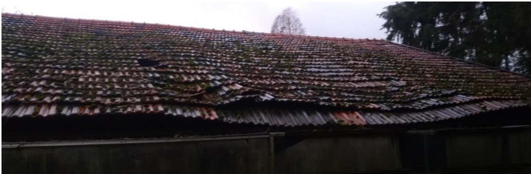
Dak van de (kippen-)schuur
