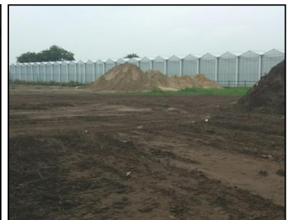
Figuur 5. Opgestuwd zand op de onderzoekslocatie.
