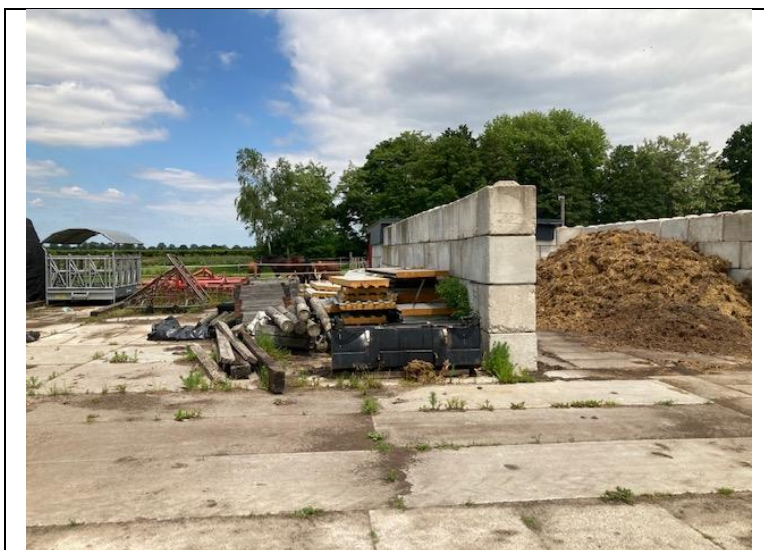
Foto 06 achterterrein met mestopslag
