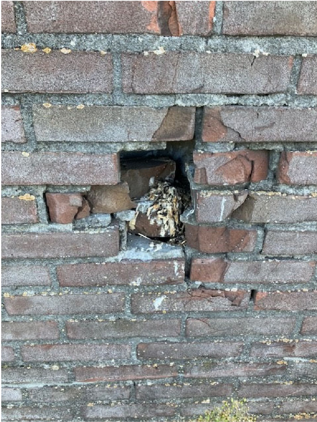
• Afbeelding 8: spreeuwennest in spouw op 1 meter hoogte
