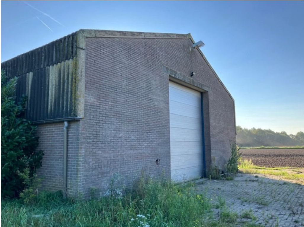
• Afbeelding 9: Achterzijde te behouden schuur
