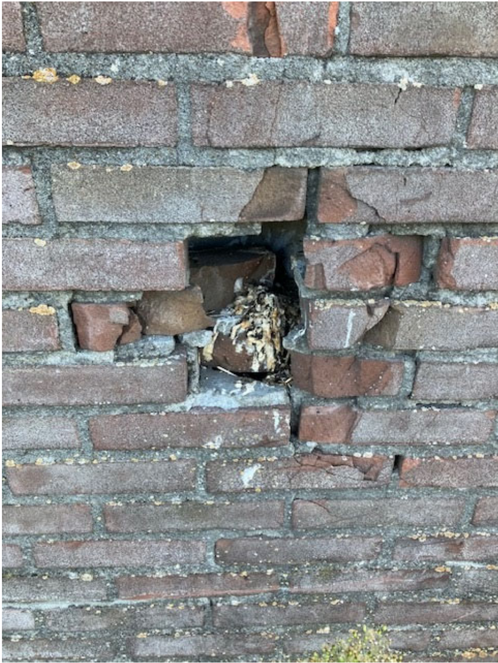
• Afbeelding 8: spreuwenest in spouw op 1 meter hoogte
