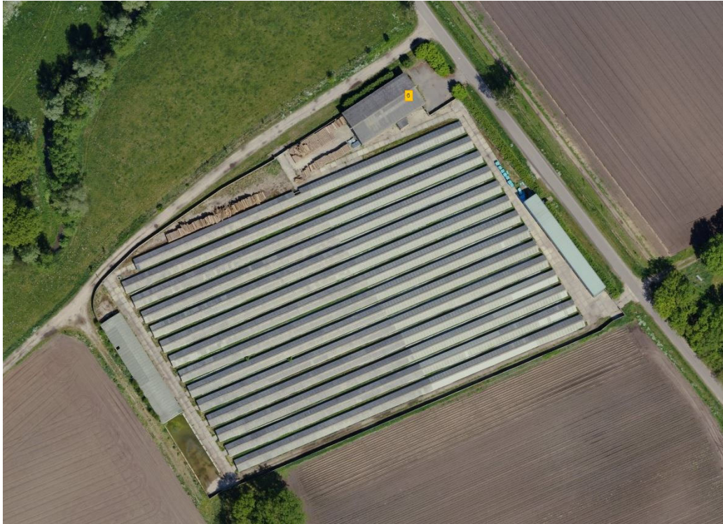
• Afbeelding 2: luchtfoto detail plangebied voor sloop sheds (bron: streetsmart.cyclomedia.com/streetsmart , geraadpleegd op 08/09/2023)
