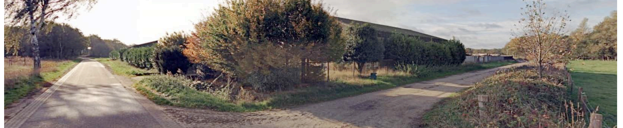
...plangebied toont zich introvert, de gebouwen worden omzoomd door hagen en een bomenrij.
