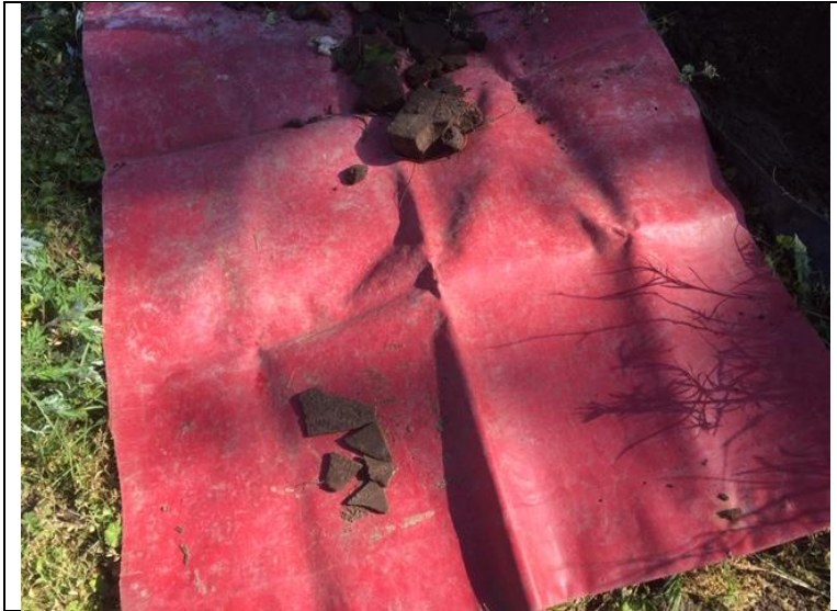
Foto 4: uitkomend asbestverdacht materiaal proefsleuf 31 (14 mei 2019)
