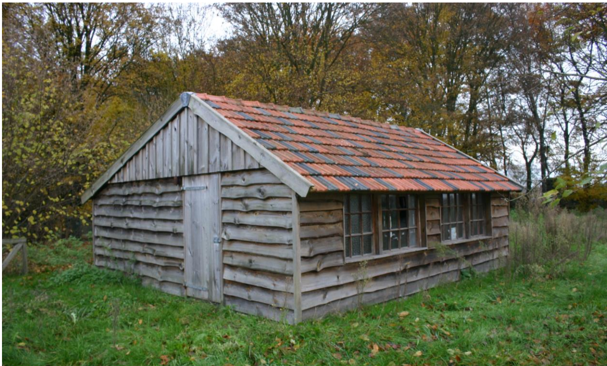
Figuur 4.2.3. Het stalletje heeft geen overstekende gevelpannen of dakgoot en is erg laag bij de grond; daarmee is het niet geschikt voor huismus- of gierzwaluwnesten.
