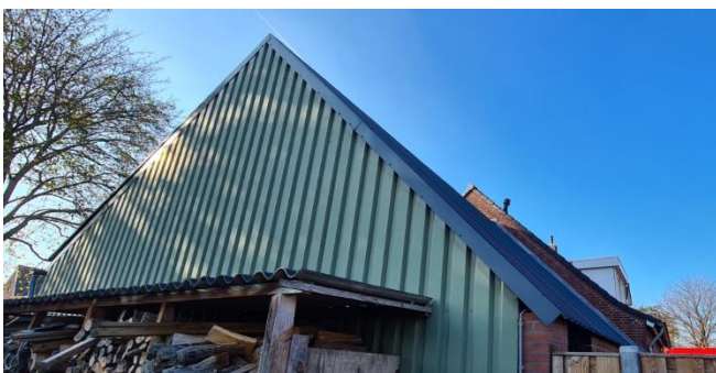
Figuur 7: Dakrand van de schuur gezien vanuit het oosten
