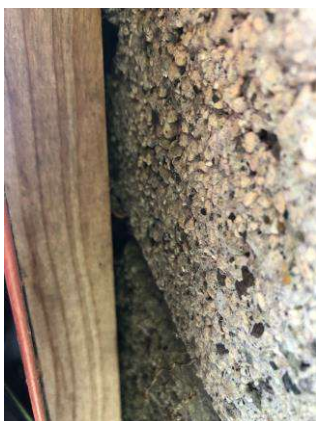
Figuur 4.2.3. De windveer zit met een lat naadloos op de gevel bevestigd.
