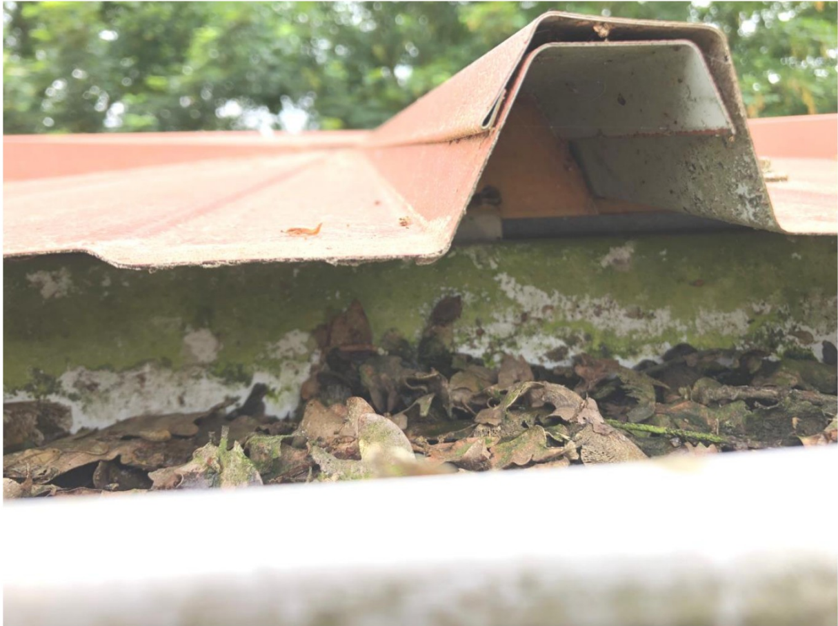
Figuur 4.2.1. Vogelschroot onder de dakpanelen.
