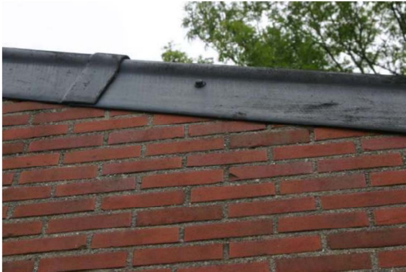
Figuur 4.4.3. De windveer op de voorzijde van de werkloods sluit nauw aan op de gevel.
