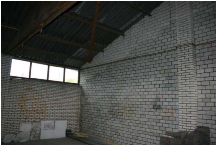
Figuur 4.4.2. In de zijgevels van de werkloods zijn de spouwen van boven afgesloten
