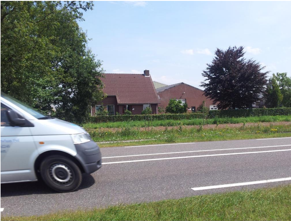
Foto 1: aanzicht op bestaande bebouwing gezien vanaf de Venloseweg
