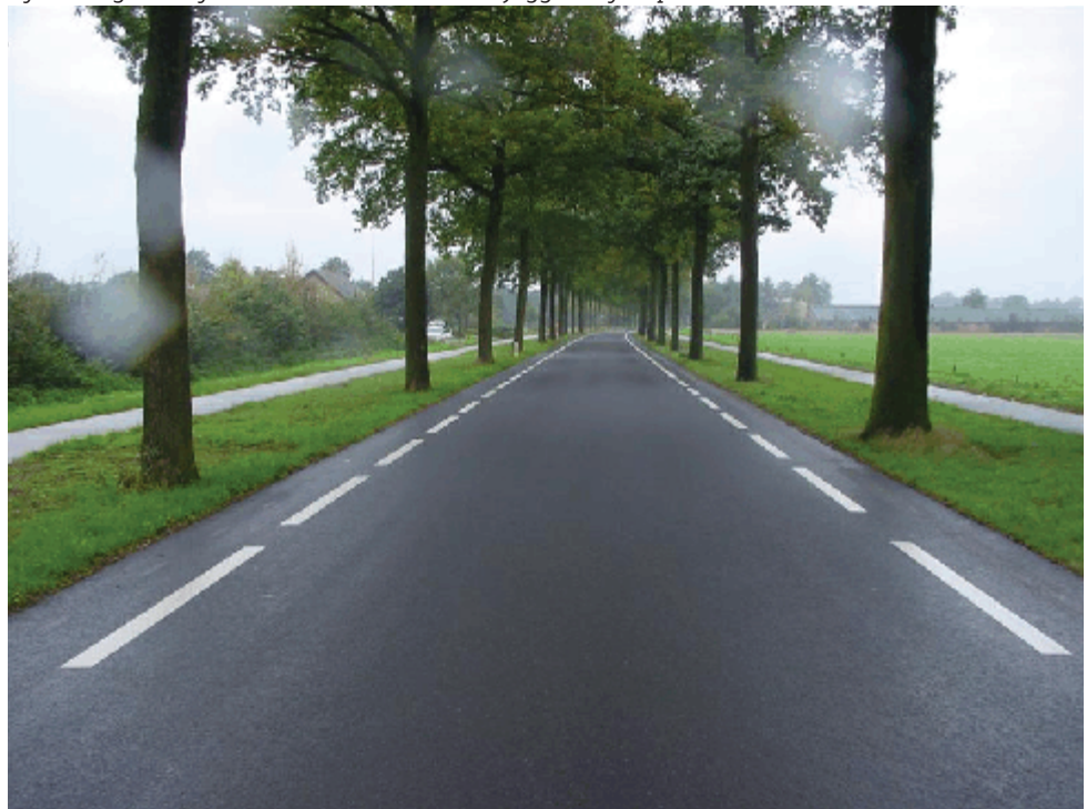
Afbeelding 11: Referentiebeeld ETW-I met vrijliggende fietspaden
