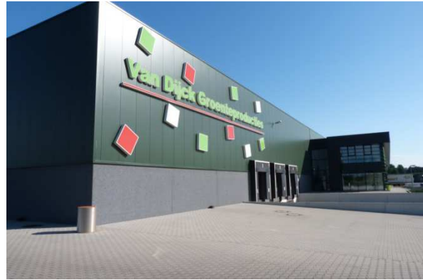
Gevel van bedrijfshal
