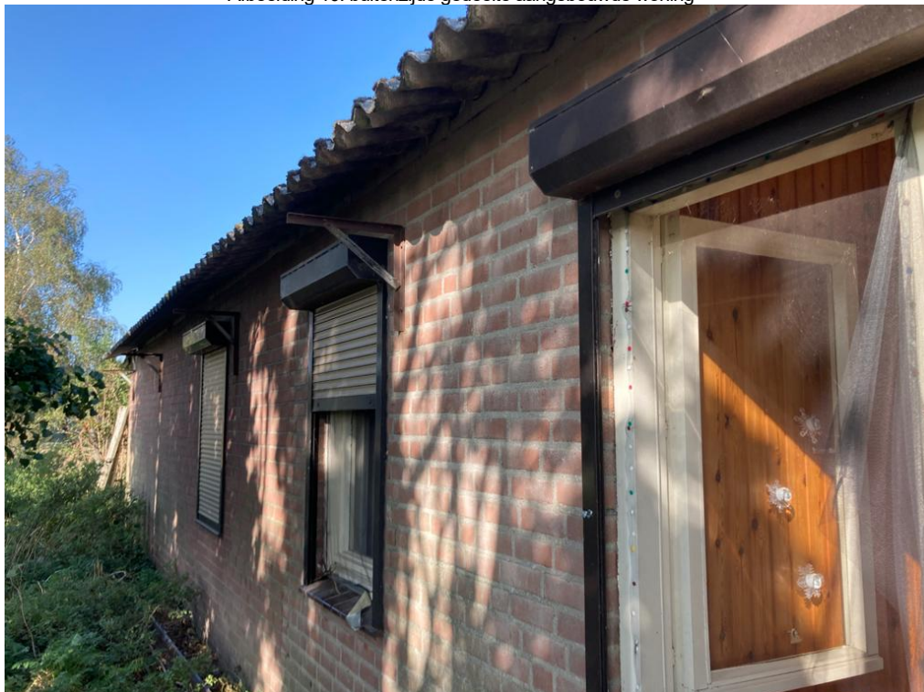
• Afbeelding 10: buitenzijde gedeelte aangebouwde woning
