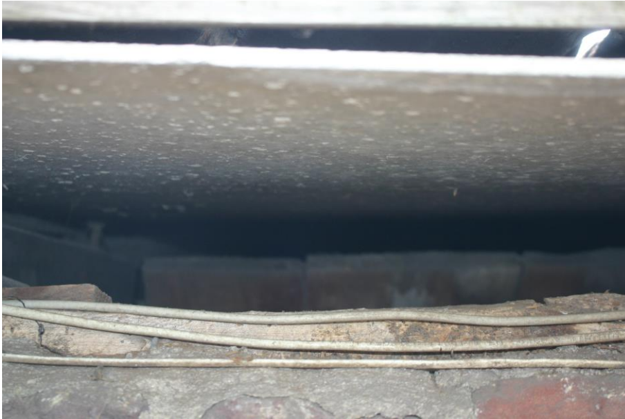
Figuur 4.2.1. Tussen het dakbeschot en de voorgevel is een ruimte aanwezig waarin vogels kunnen broeden. Hier zijn echter nergens vogelnesten aangetroffen.
