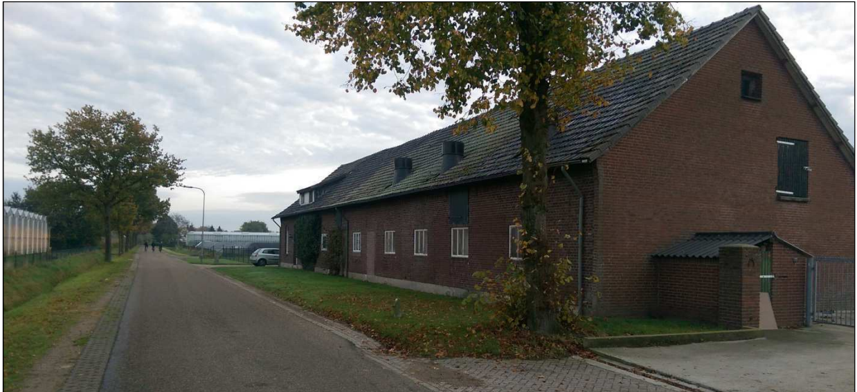
Figuur 5 Te slopen bedrijfswoning en biggenstal
