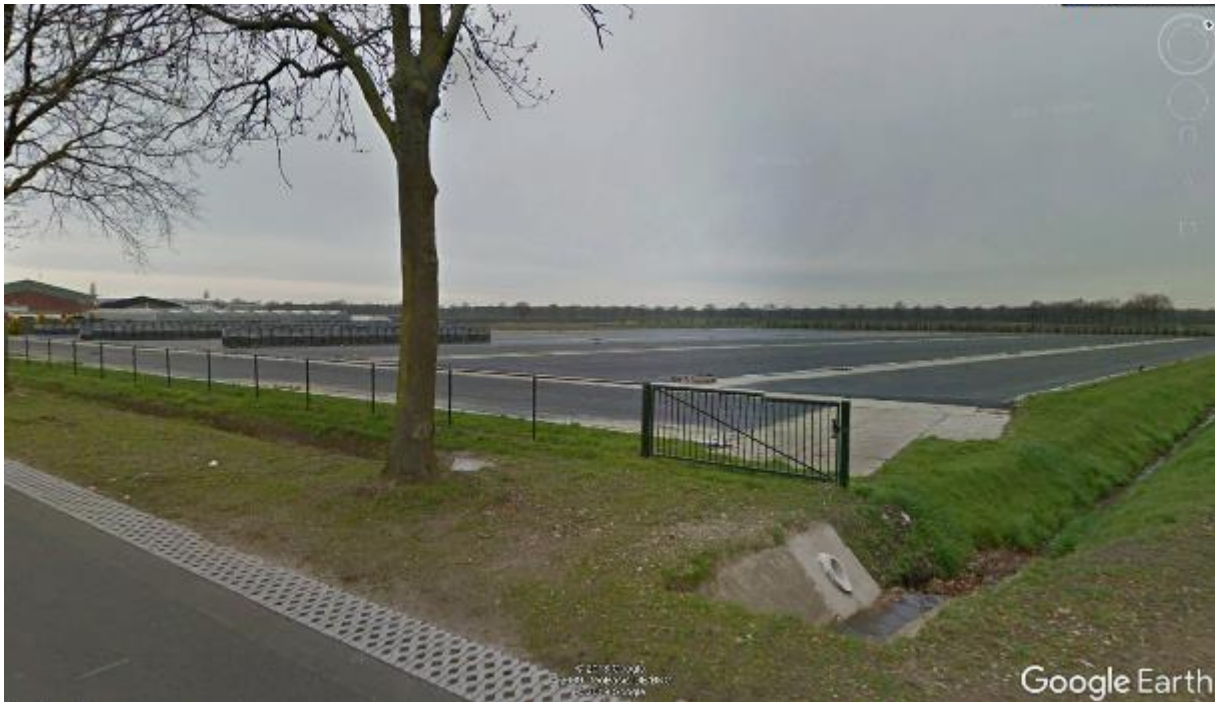
afbeelding 9, bestaand trayveld aan de Kempweg
