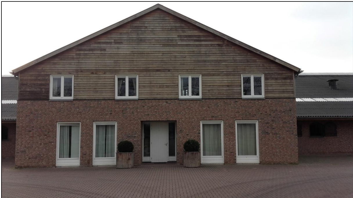
Afbeelding 2. Vooraanzicht bedrijfshal vanaf oprijlaan gezien met op de voorgrond het gedeelte waarin de appartementen zich bevinden.
