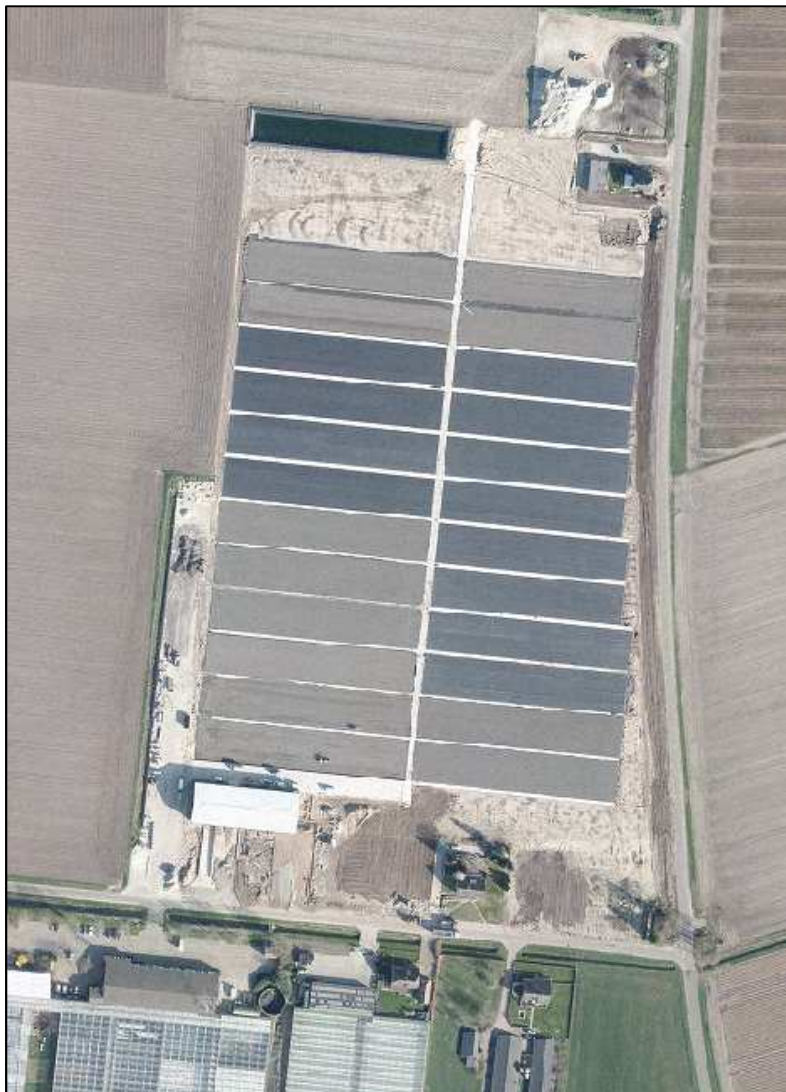
Figuur 12. Luchtfoto plangebied medio 2014 met containervelden in aanleg
