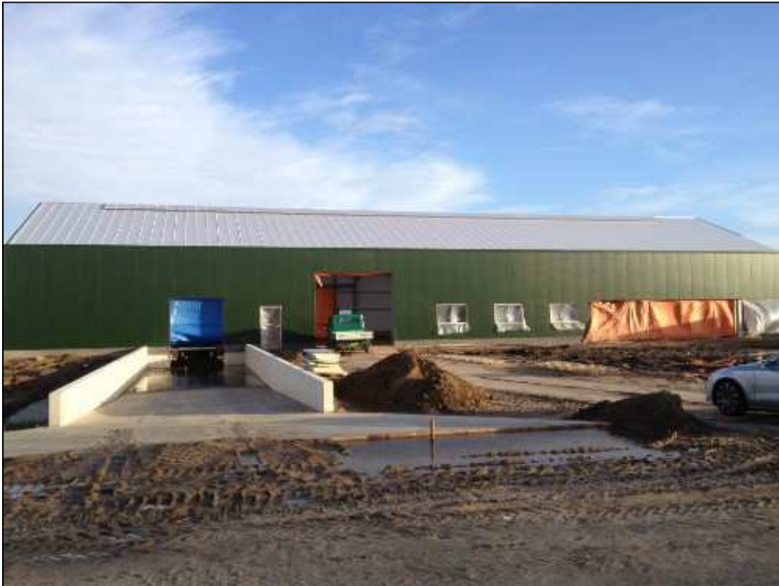
Figuur 9. Nieuwbouw bedrijfsgebouw DriesVenplant B.V. Bron: www.driesvenplant.nl
