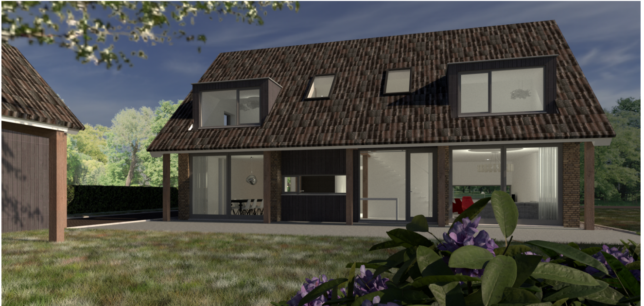
Figuur 8-2: situering woning en schuur op de kavel / achter aanzicht
