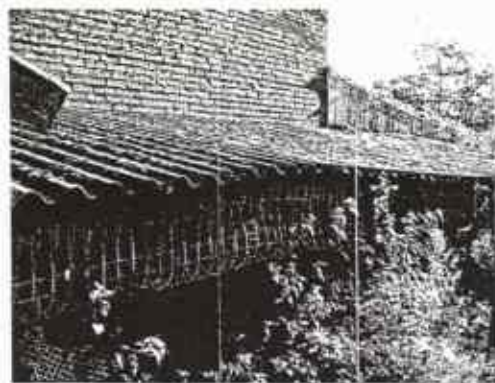
Foto 2: Golfplaten op het dak van het kippenhok (A2).
