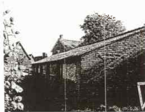
Foto 7: Golfplaten op het dak van schuur 2 (M3).
