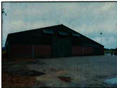
Figuur 3. Aanwezig schuur op locatie
