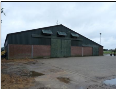
Figuur 3. Aanwezig schuur op locatie
