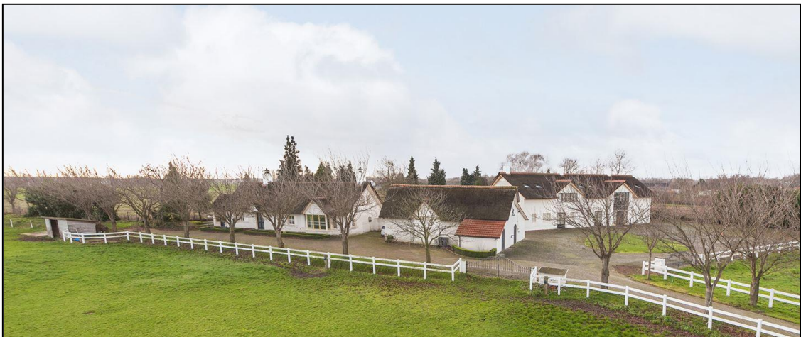
Figuur 3 Vooraanzicht woning (links), paardenstal (midden) en hotelgebouw (rechts)
