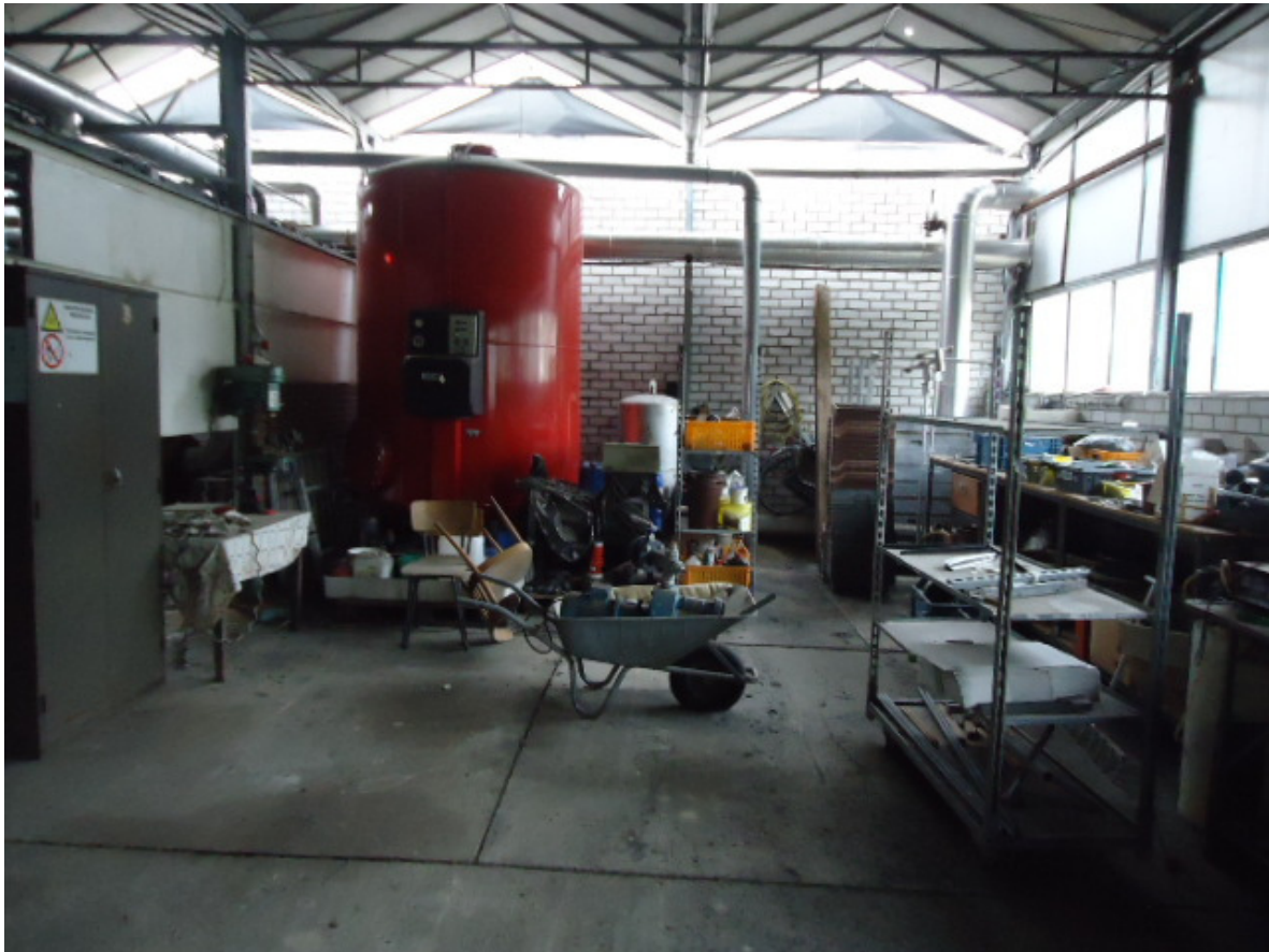
Foto 3: Voormalige werkplaats met niet meer in gebruik zijnde bestrijdingsmiddelen kast en drukketerl voormalige c.v.-installatie (gezien vanuit het oosten, 31 maart 2014)
