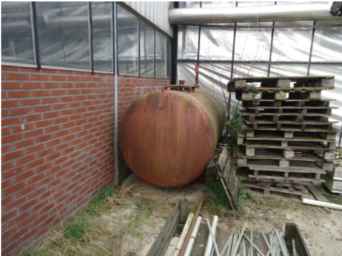
Foto 6: Voormalige, sinds 2004, niet meer in gebruik zijnde bovengrondse HBO-tank van 2.000 liter (gezien vanuit het oosten, 31 maart 2014)
