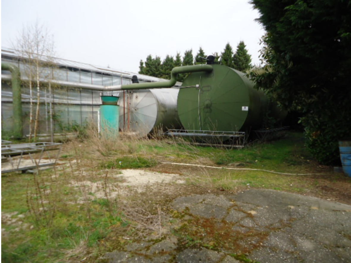
Foto 5: Ligging voormalige WKK-centrale met de nog aanwezige twee buffertanks (gezien vanuit het zuidoosten, 31 maart 2014)
