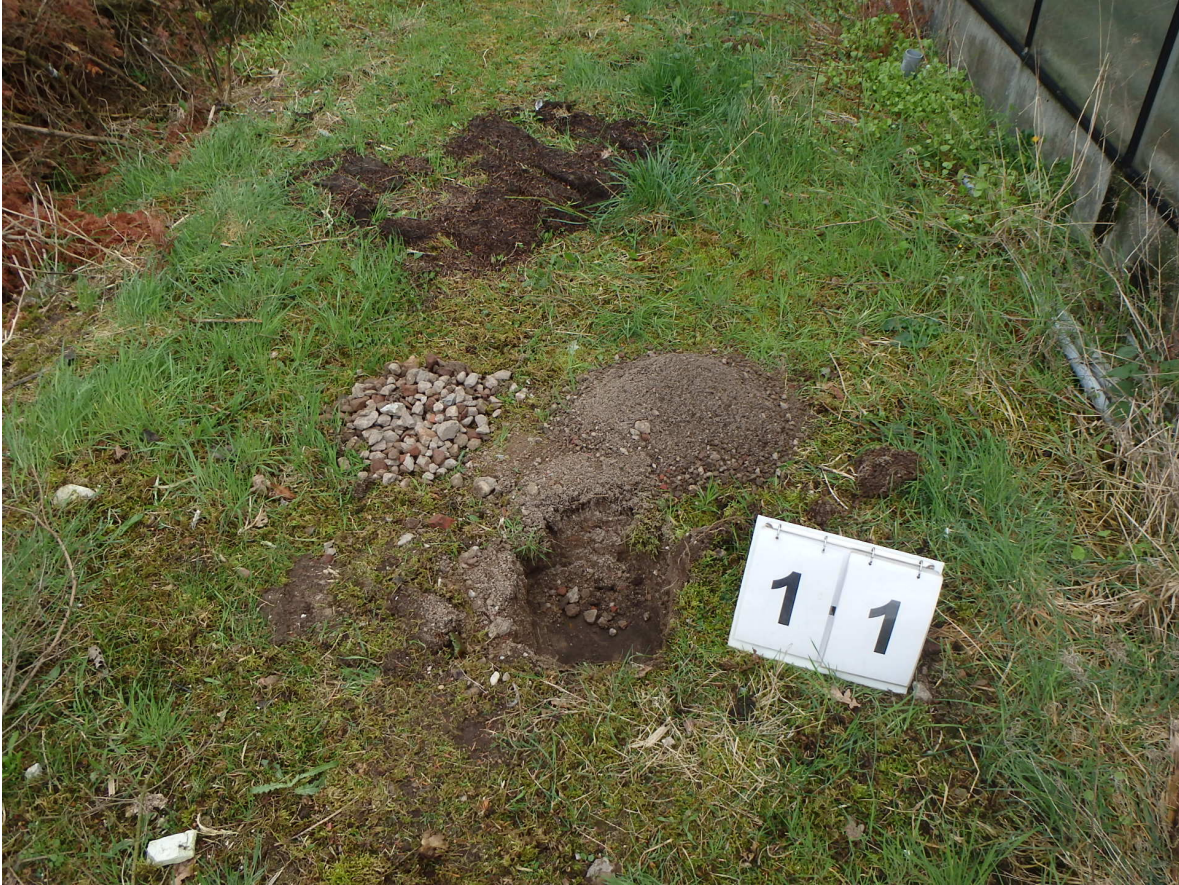
Foto 16: Inspectiegat IG11 puinverharding met uitkomend gezeefd materiaal ( 9 april 2014)
