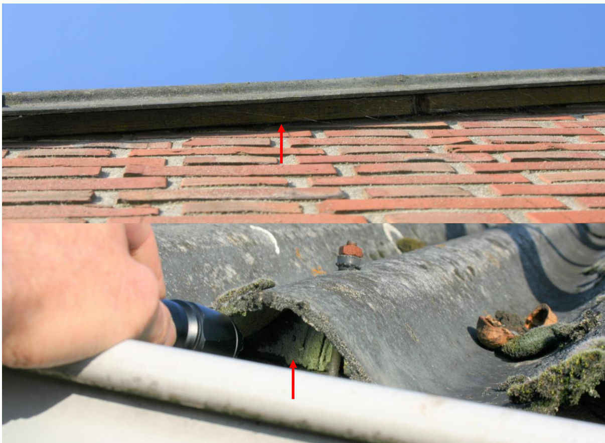
Figuur 4.2.1. Het golfplaten dak sluit nauw aan op de gevels; op de kopse kant (bovenste foto) door middel van een houten lat en op de zijgevels (onderste foto) is de ruimte onder de ‘golven’ opgevuld met specie (zie rode pijlen).
