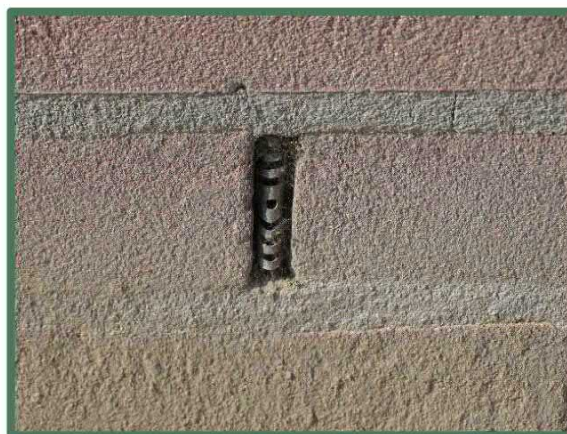
Foto 21 & 22: Bijenbekjes in stootvoegen.
