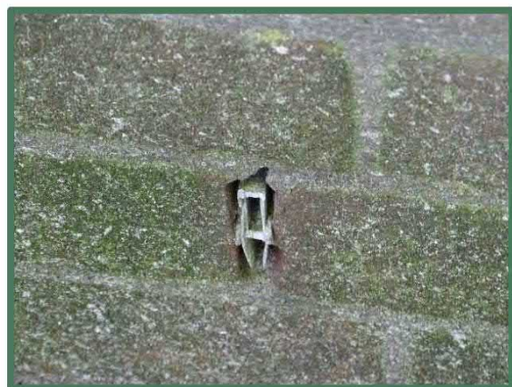
Foto 21 & 22: Bijenbekjes in stootvoegen.
