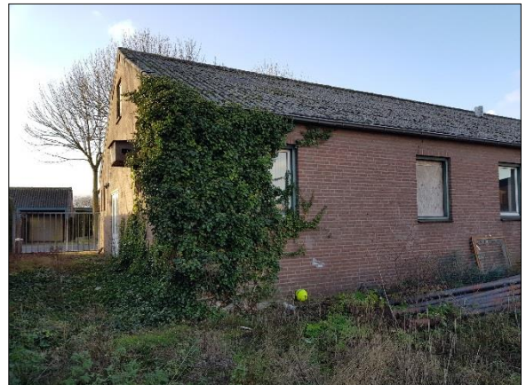
Figuur 9. Noordzijde gebouw
