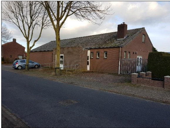
Figuur 4. Gebouw vanaf zuidwesten
