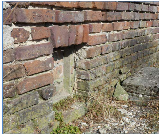
Foto 17 dicht gedeelte dubbele muur gebouw 1 zonder spouw
