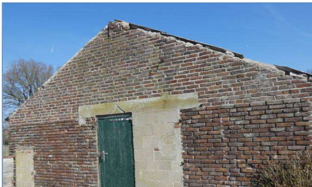
Foto 7 en 8 kopgevels gebouw 1 zonder overstekken of windveren
