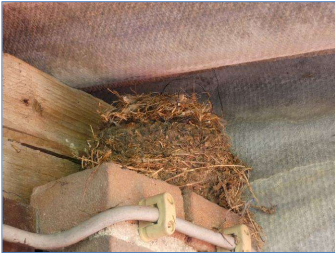
Foto 4 verlaten nest merel op zijmuur tegen voorgevel W gebouw 2
