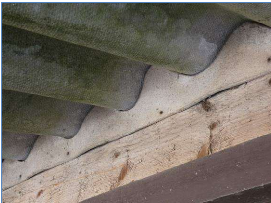
Foto 12 'plaat-golfafdichting' gebouw 2
