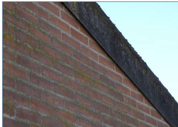
Foto 13 strakke afdichting kopgevels gebouw 2
