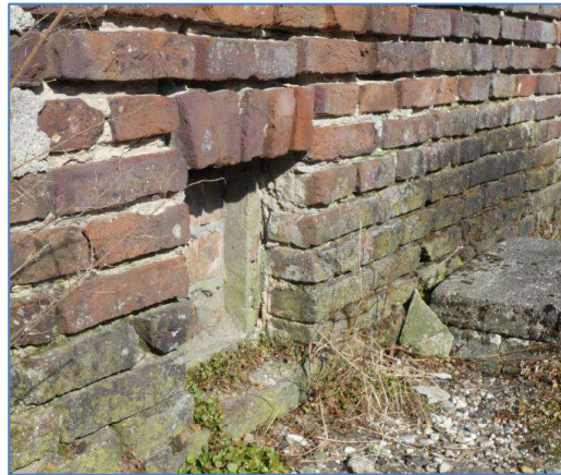
Foto 17 dicht gedeelte dubbele muur gebouw 1 zonder spouw
