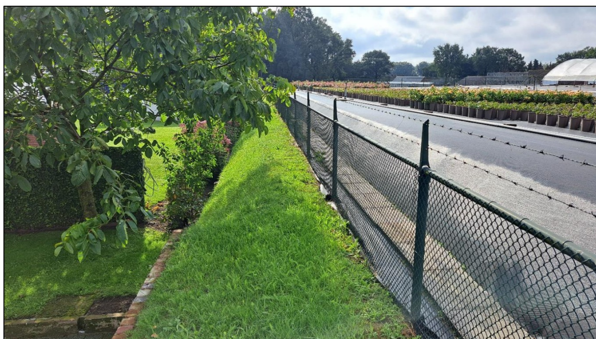
Foto 1: Steilwand aan de zuidrand van het plangebied
