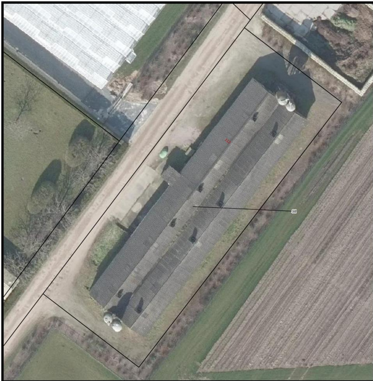
Afbeelding 8 Luchtfoto huidige situatie plangebied Horsterdijk 112
