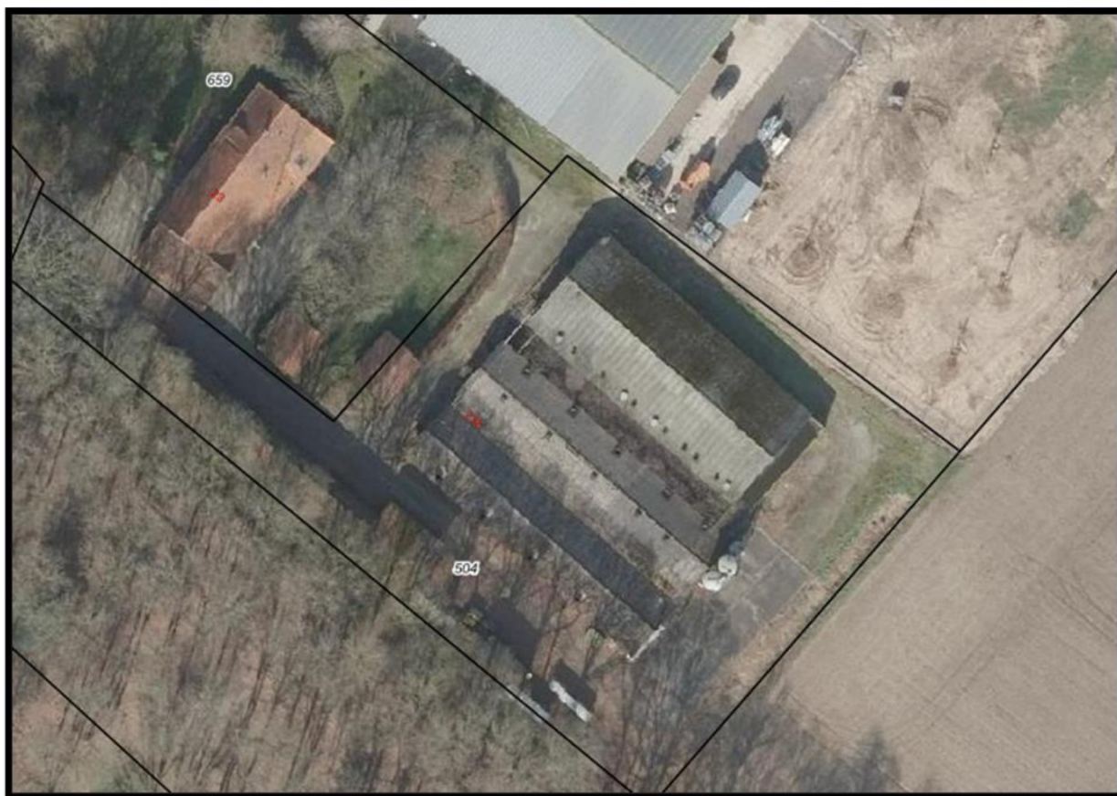
Afbeelding 9 Luchtfoto huidige situatie plangebied Horsterweg 23/23b
