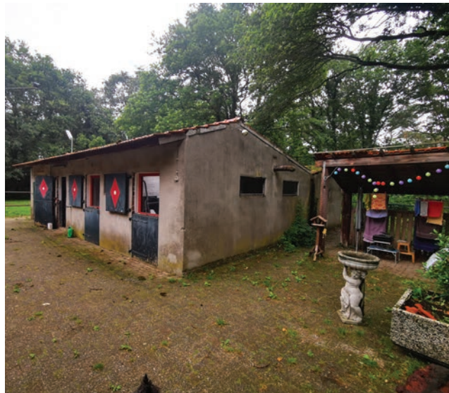
Beeld 3. Te slopen bijgebouw
