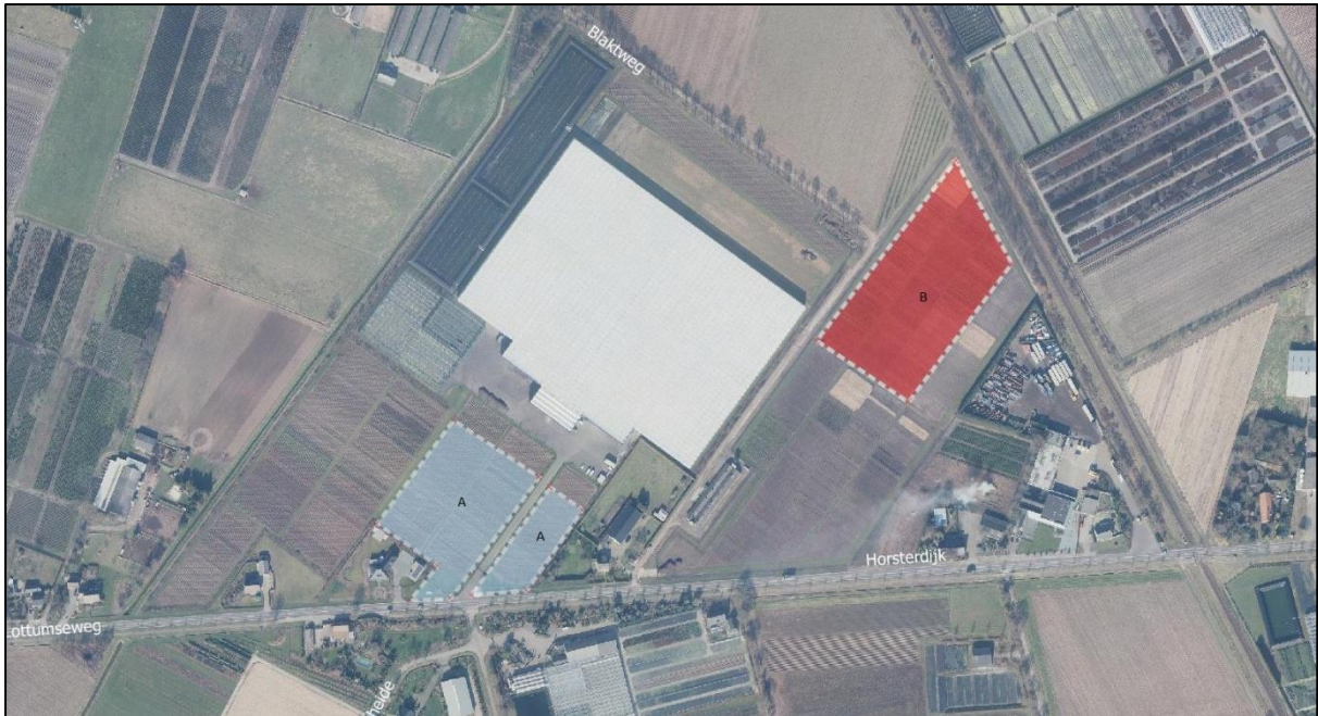
Figuur 2. Luchtfoto onderzoekslocatie (terreinen A en B) en directe omgeving.
